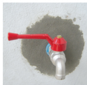
งานซ่อมอุดประรอยแตก รอยเจาะฝังท่อ
